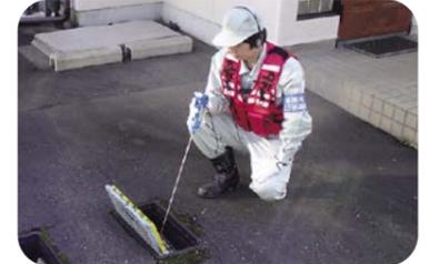
漏水音を聴く道具などを使って、漏水箇所の確認をしています。
