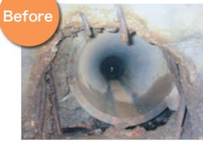
腐食により鉄筋が露出しています。
