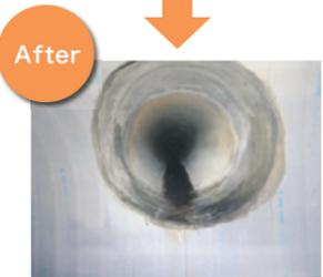
腐食部分を補修し、管の長寿命化を図りました。
