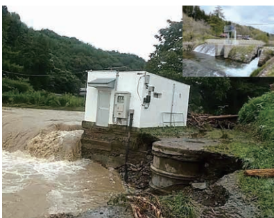
災害発生翌日の取水口
