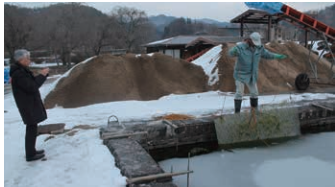
併せて同局が考案・特許を取得した緩速ろ過池の抜き取り機による作業内容も確認
