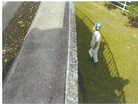
【写真 18 外壁塗膜上端部】
