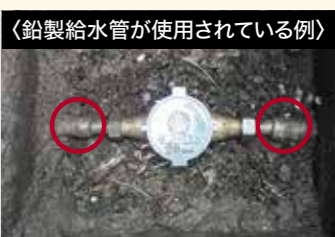
鉛製給水管が使用されている例 鉛製給水管は、赤く囲っている部分が鈍い灰色をしています。
