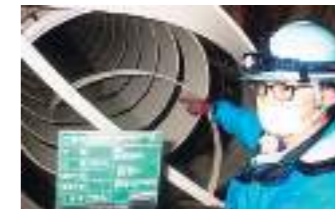
工事の立ち合いの様子です。直径1.1メートルの管に資材を巻いています。
