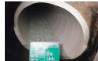
工事後の写真です。改築更新後は、50年以上使用できる下水道管になります。
