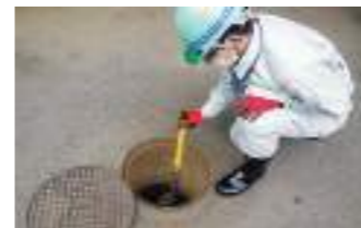
完了検査では、不具合なく流れるか専用の鏡で確認します。
