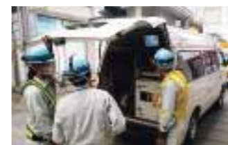
詰まり解消後、下水道管の中にカメラを入れて、内部を確認している様子です。
