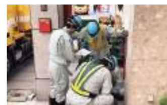
下水道の詰まりを高圧洗浄で取り除いてる作業を現場監督している様子です。
